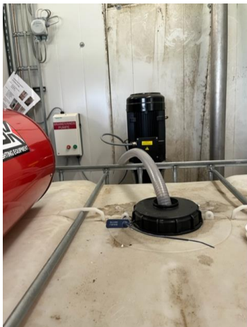
Foto 4: Tilkoblingssted på mobil pallettank
