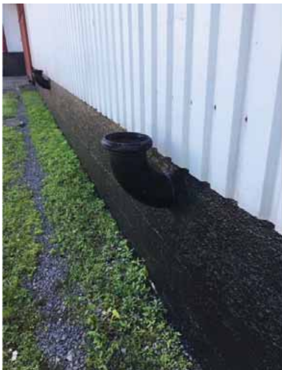
Figur 8 Billede af maskinhal (stald 1) med udendørs 'sugerør'.
