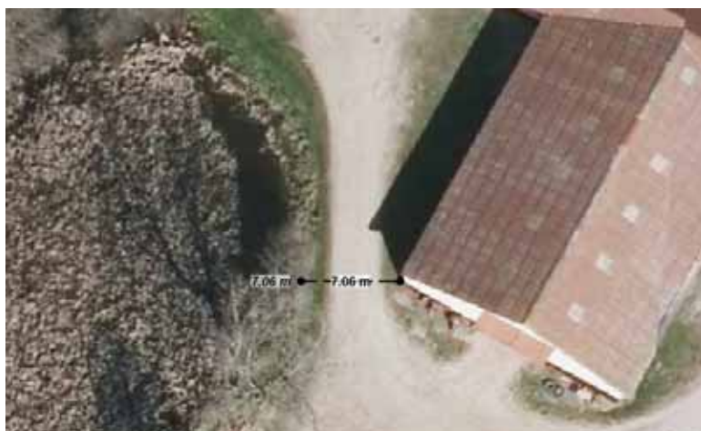
Figur 5. Søen beliggende ca. 7 m fra nærmeste staldhjørne
