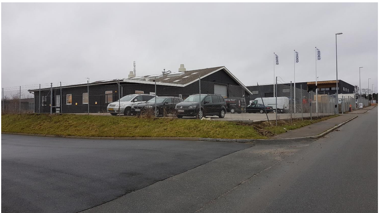
Billede af autoværkstedet taget ved tilsynet.
