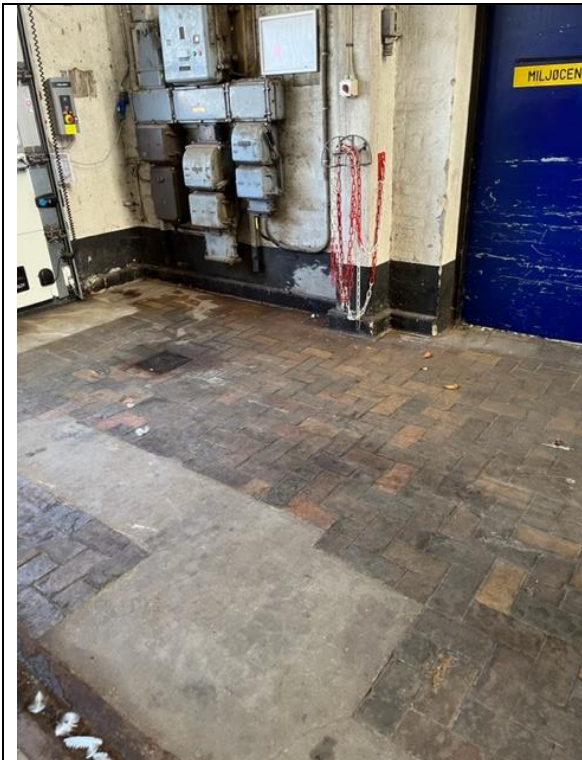
Afløb ved brandslukningsanlæg i hallen overfor olierummet, hvor skum vil løbe til olieudskiller og til kommunalt renselanlæg.
