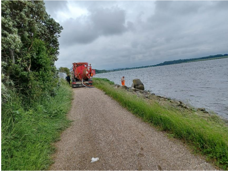
Næstved Havn spuler udledningsrør fra udløbsbrønd ud i fjorden
