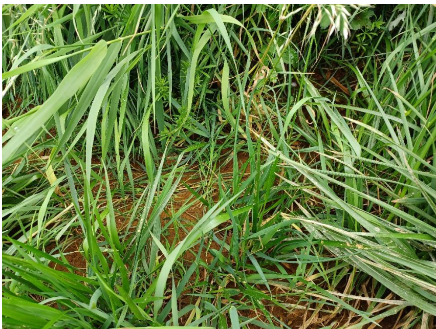
Vådt yderside af dige ved østligste vandpyt
