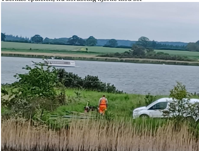
Ydernæs spulefelt, fra nordøstlig hjørne mod syd og pumpe ved bassin 2
