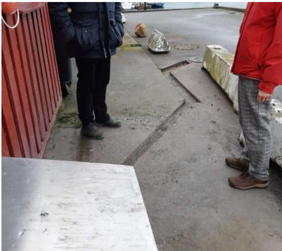
Afløbsrende skåret i betonen for eventuelt oliespild over til olieudskiller
