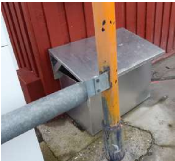
Metalkasse over udluftninger. Afløbsrende kommer ud til højre fra kassen
