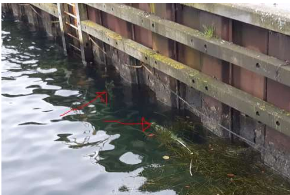
Offeranoder på spunsvæggen under vandet – ud for området med membran
