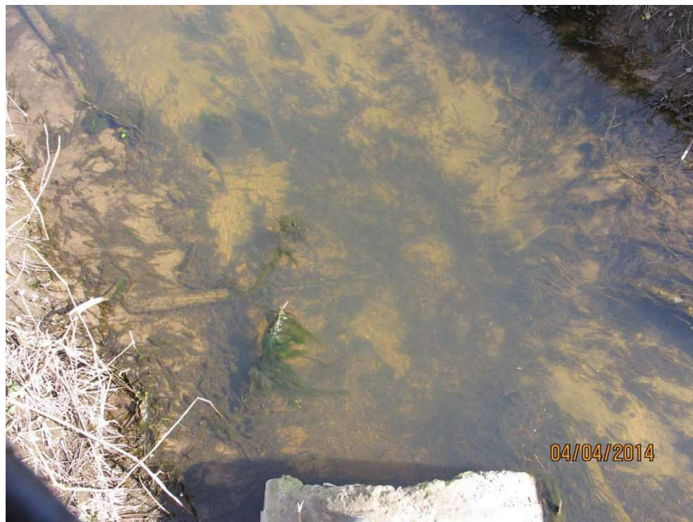
Figur 2-5 Bundtopografi ved udlob fra pumpebrønd. Der ses en fordybning umiddelbart ud for rørets udlob. Der blev observeret sporadisk udstømning.
