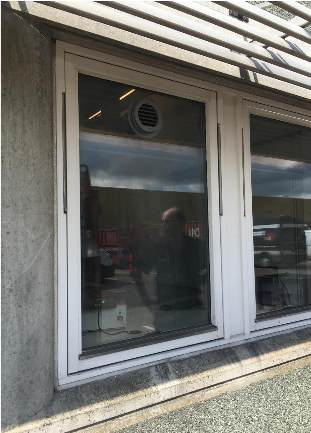
Figur 1: Vinduet hvorfra luften fra stinkskaftet ledes ud.
