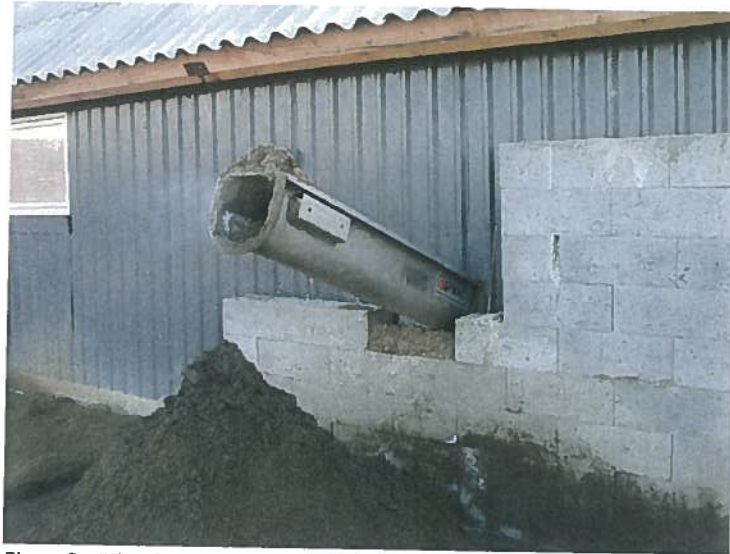
Figur 2. Fiberfraktionen føres via snegl til betonplads.
