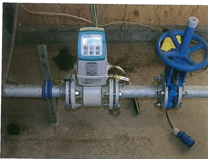
Figur 4. Mængden af behandlet rågylle er målt ved brug af en Siemens flowmåler.
