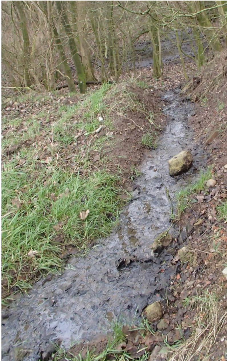
Foto 2: Afløb fra stakken mod øst. Randen er gravet for at tage overfladevandet fra den markvej, der går mod nord. Der er kraftig hældning fra markarealerne ned mod dette hjørne.
