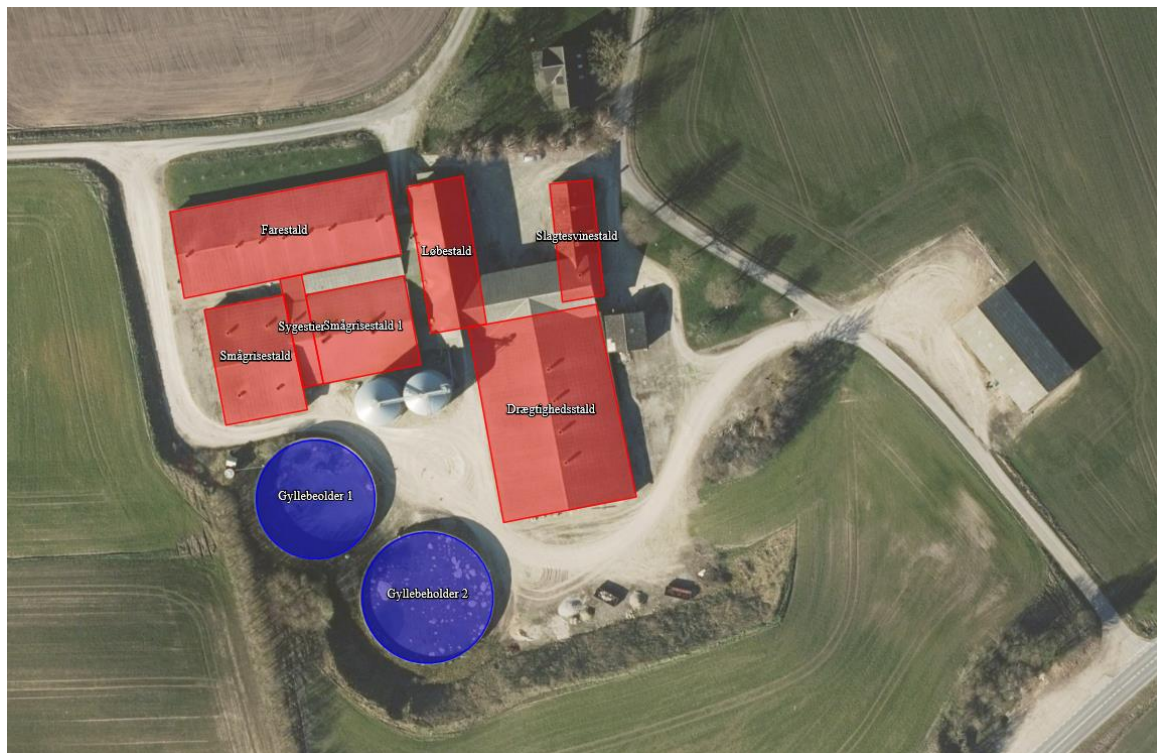
Figur 1. Staldafsnit og opbevaringsanlæg på Koustrup 4, 8560.
