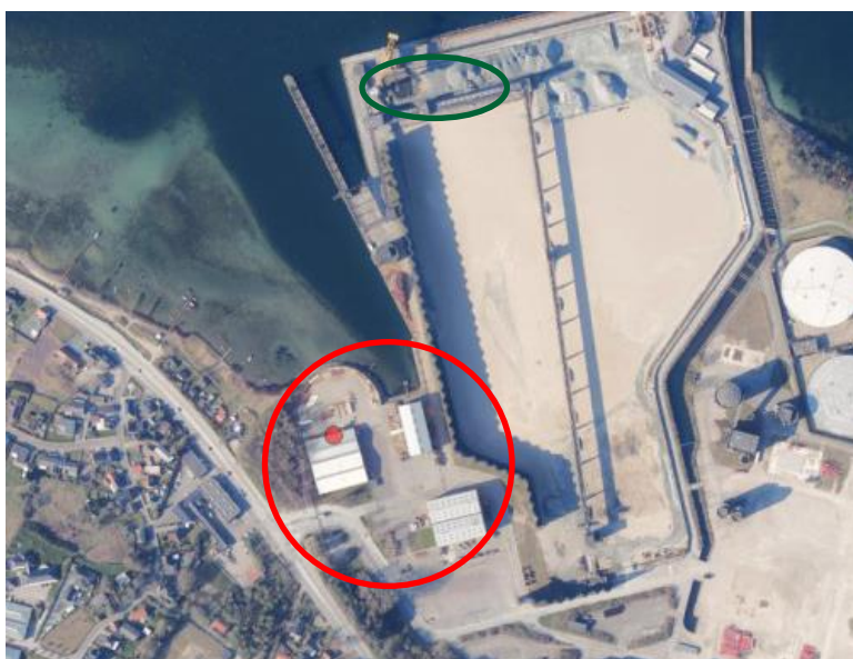
RIMECOs site (rød cirkel) udleder overfladevand via havnens anlæg (grøn oval) med olieskimmer ved bygning (th. i ovalen) og forsinkelsesbassin (tv i ovalen/ved den gule kran)
