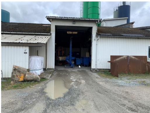
Foto af indgang til påfyldningsplads for dieselolie og AdBlue
