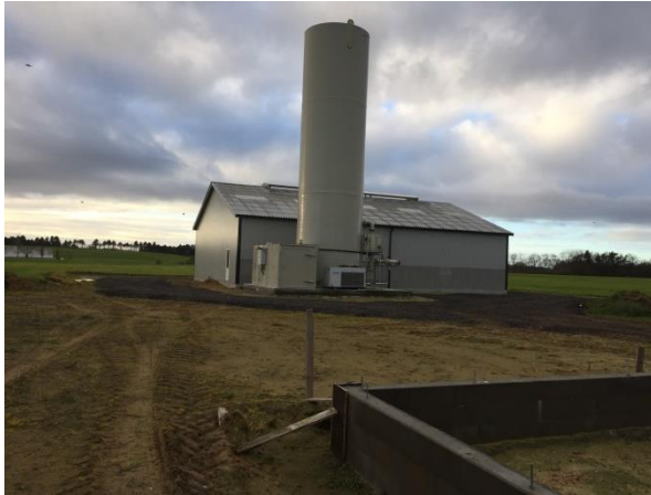
Billede nr. 1 (2018): Ny bygning til gaslager samt nyt afsvovningsanlæg
