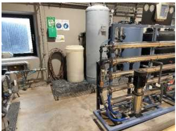
Oplag af natronlud med risiko for afløb til kloaksystemet.
