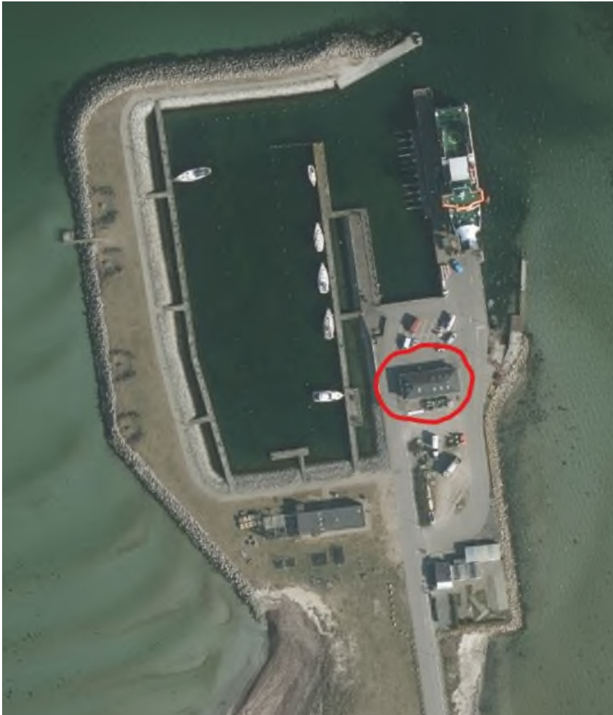
Figur 1: Bygning til oplag af farligt affald, Endelave Havn 1, Endelave.
