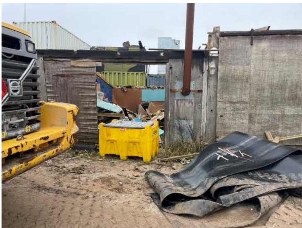
Figur 8 Bygning som rives ned (bygning 3, Farmerstien 8, på BBR)
