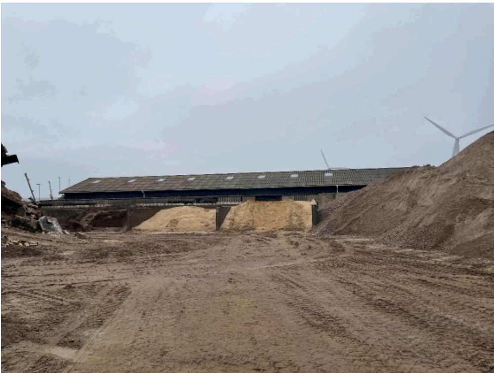
Figur 6 Oplag af sand og jord. Her ønskes senere opført tag over en del af området, som til den tid skal fungere som oplagsplads for lettere forurennet jord.
