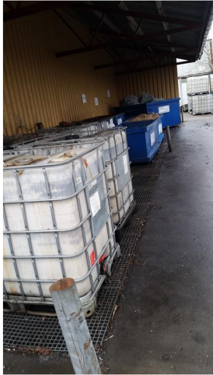
Opbevaring af flydende farligt affald og spåner med kølesmøremidler under tag og over grav til opsamling af lækager
