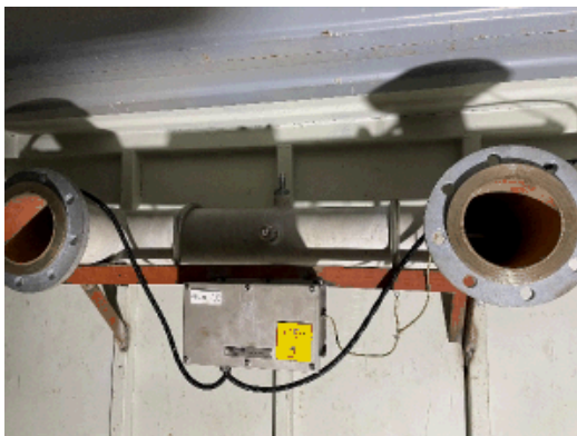
Rensningsenheder til fremtidig rensning af ballastvand (ozonenhed og filterenhed)
