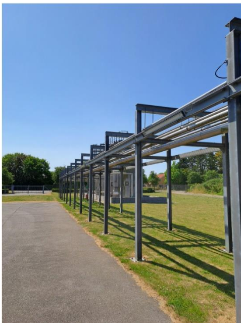
Foto 1 og 2: Ethanolrør over græs uden tæt belægning
