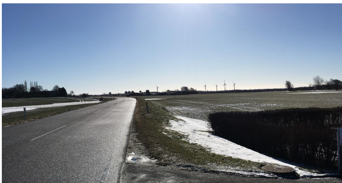
Foto 1: Gården opleves tydeligt fra Lundbyvej, når man kører mod øst og man kommer fri af den sidste husrække i Køng. Landskabet er fladt og præget af tekniske anlæg (vindmøller) og gården med store staldanlæg og siloer.
