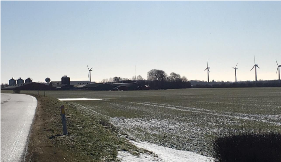
Foto 2: Gården fremstår dominerende i landskabet og ses tydeligt fra hele strækningen fra Næstvedvej ad Lundbyvej, til man kommer til Køng Kirkevejen, hvor jordvolden skjuler gården langs Lundbyvej. 4 gavle, deres tilhørende tagflader og siloerne ses herfra.
