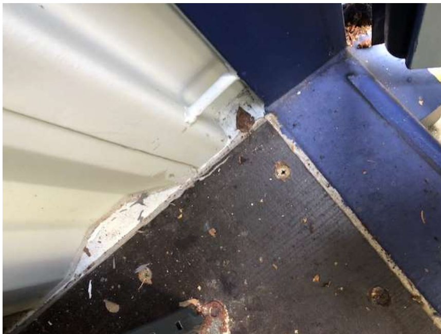
Gulv i container med fugning langs kanter
