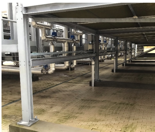
Belægningen med indbyggede varmelegemer
