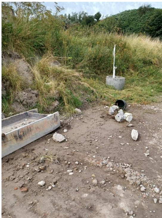
Figur 8. Monitoringsboring DGU 26.6464. Øverst tv: Boringens omgivelser. Øverst th: Boringsskilt fastgjort til filterør. Nederst tv: Knækket top på filterør. Nederst th: Skrabemærker i jorden foran DGU 26.6464. Området foran boringen udgør Nordværks sorteringsplads.
