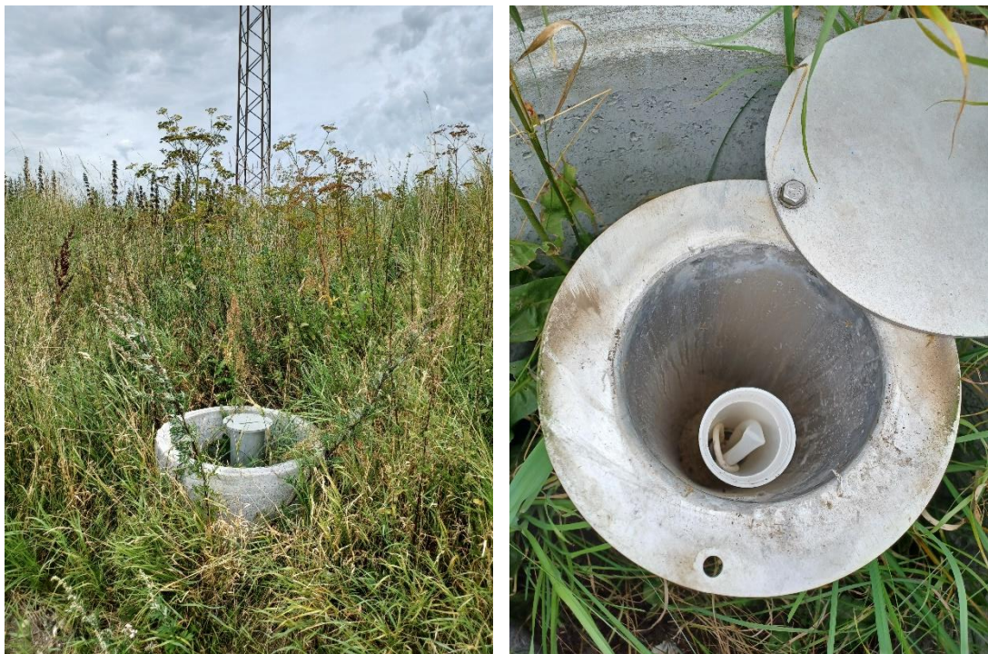
Figur 9. Boring med DGU-nummer 26.6931 placeret i volden tæt på samlebrønden for spildevand fra pladsen. Tv: Boring med omgivelser. Tv: Kig ned i boring. Prop er taget af filterrør.
