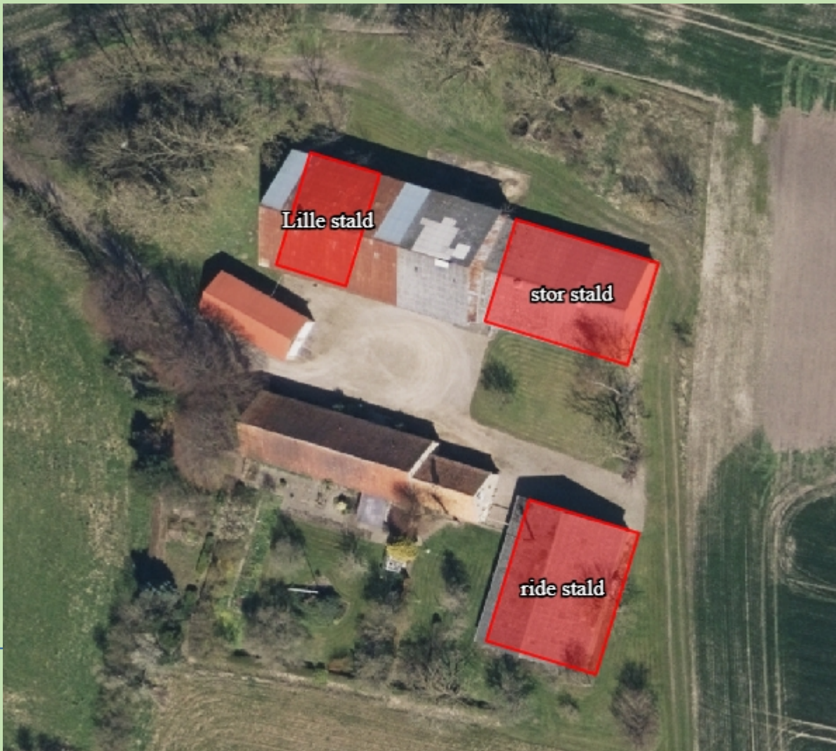
Figur 3: Oversigt over ejendommens staldanlæg.
