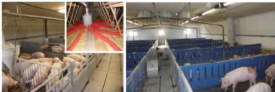
Figur 5. Billedet til venstre viser punktudsugning i en førestald med kassestier. Under det faste gulv i kassestierne er etableret en tværkanal med én dyse pr. førest. Luften samles på loftet i en hovedkanal. Billedet til højre viser en førestald med liggende drægtende søer, hvor punktudsugningsanlægget er etableret på tilsvarende måde som i førestalden med kassestier.
