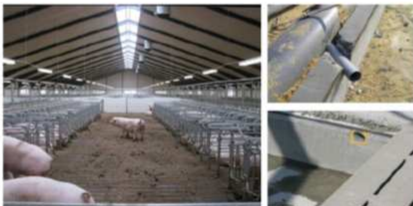
Figur 2. Punktsugning etableret i en drægtighedsstald med læsgående søer, en ødeboks pr. sø. De to billeder til højre viser placering af dyser og førkanal, som er placeret under gulvet i boksrækkerne.
