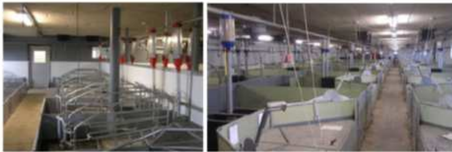
Figur 5. Billedet til venstre viser punktudsugning i en førestald med kassestier. Under det faste gulv i kassestierne er etableret en tværkanal med én dyse pr. førest. Luften samles på loftet i en hovedkanal. Billedet til højre viser en førestald med liggende drægtende søer, hvor punktudsugningsanlægget er etableret på tilsvarende måde som i førestalden med kassestier.
