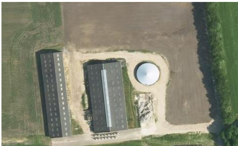
Foto 5. Skovvej 7. Luftfoto juli 2020. Det nyeste i tilgængeligt kortmateriale i Varde Kommune.
