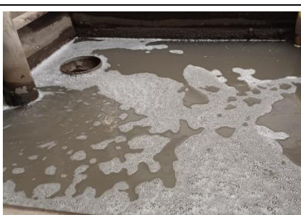
Vaskevand løber gennem sandfang før det opsamles i genbrugsbrønd hvorfra vandet genbruges til undervognsvask.
