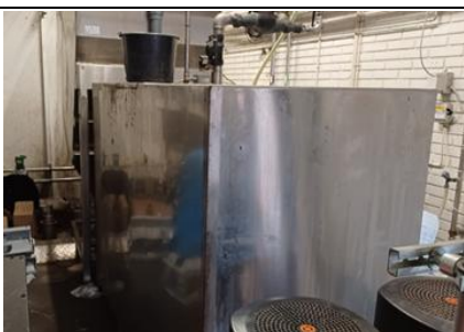
Vaskevand løber gennem sandfang før det opsamles i genbrugsbrønd hvorfra vandet genbruges til undervognsvask.
