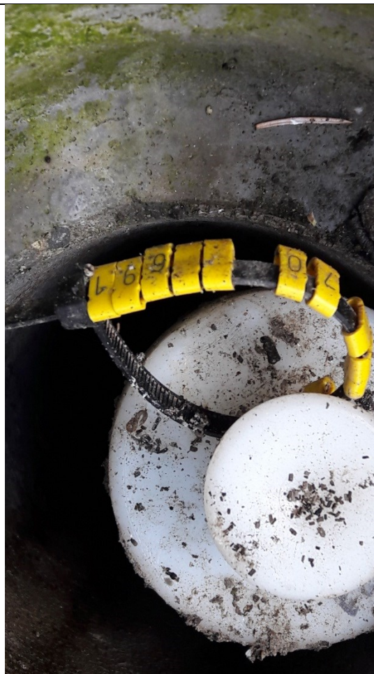
Boringen er mærket med DGU nr. Boringen er ikke forsynet med aflåseligt låg.
