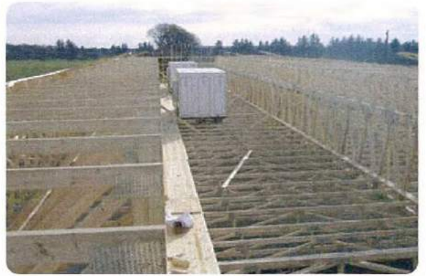
Modul indsat på loft
