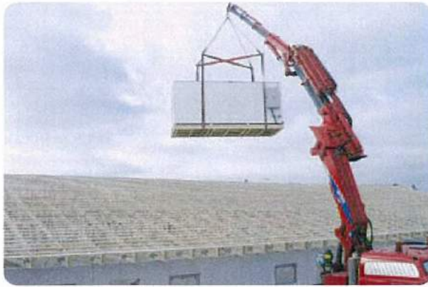
Modul sættes på plads med kran
