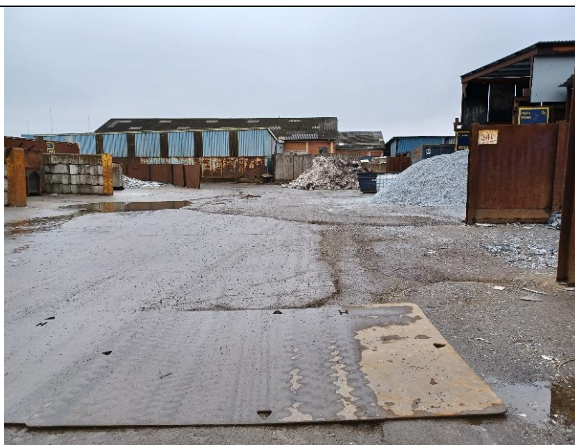
Alu-spåner uden for bås og med opstuvning af vand, da afløbet udfor båsen er stoppet.
