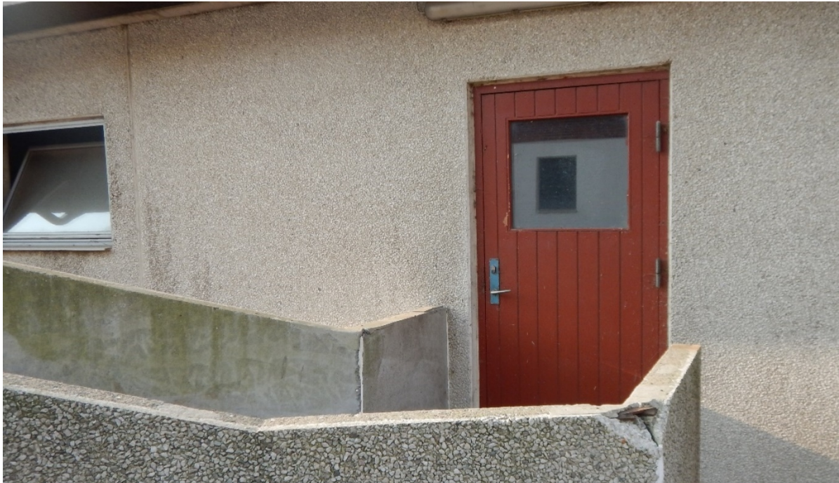
Figur 7 og 8: Staldbyggeriet er opført i betonsandwichelementer.
