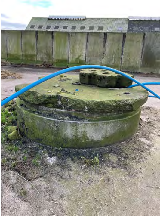
Figur 5: Billede af vandboring, hvortil afstandskravet ikke er overholdt. Kilde: LandboSyd.
