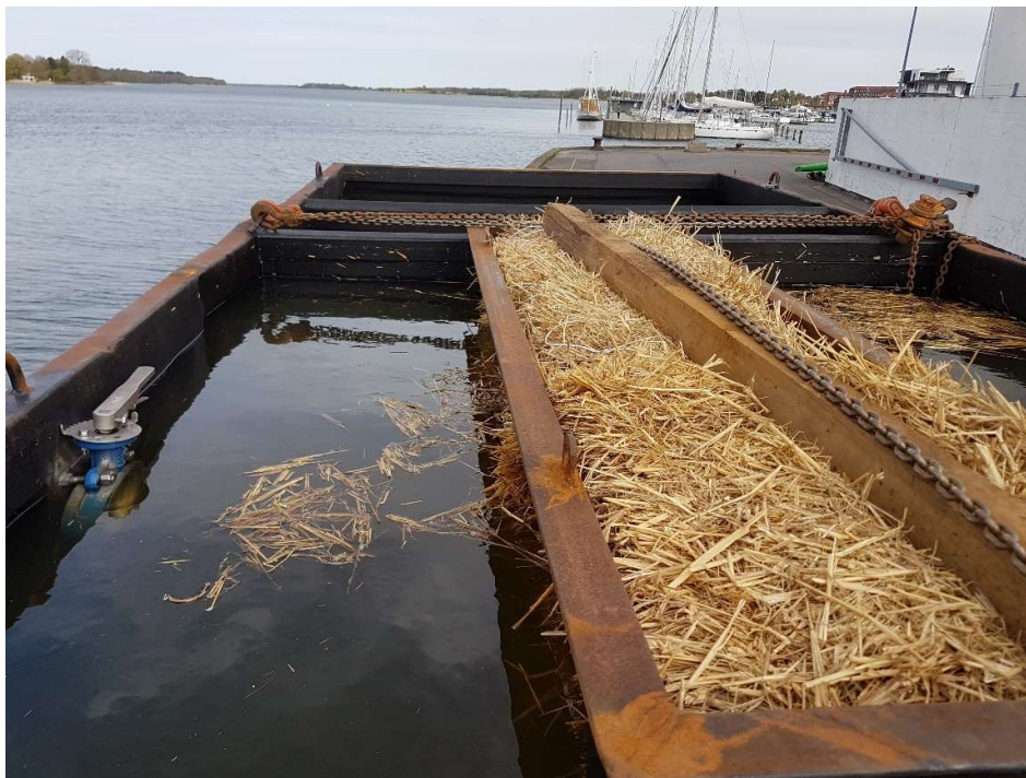
Figur 1 Container med olieudskiller og partikelfilter (halmballer). Indløb er i modsatte ende og udløb i venstre side nederst.
