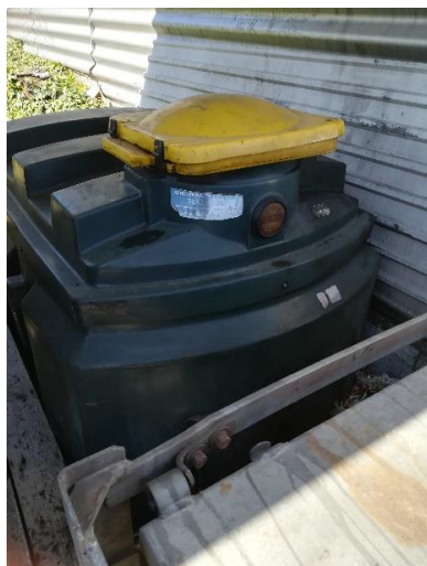
Spildolietank i opsamlingsbakke
