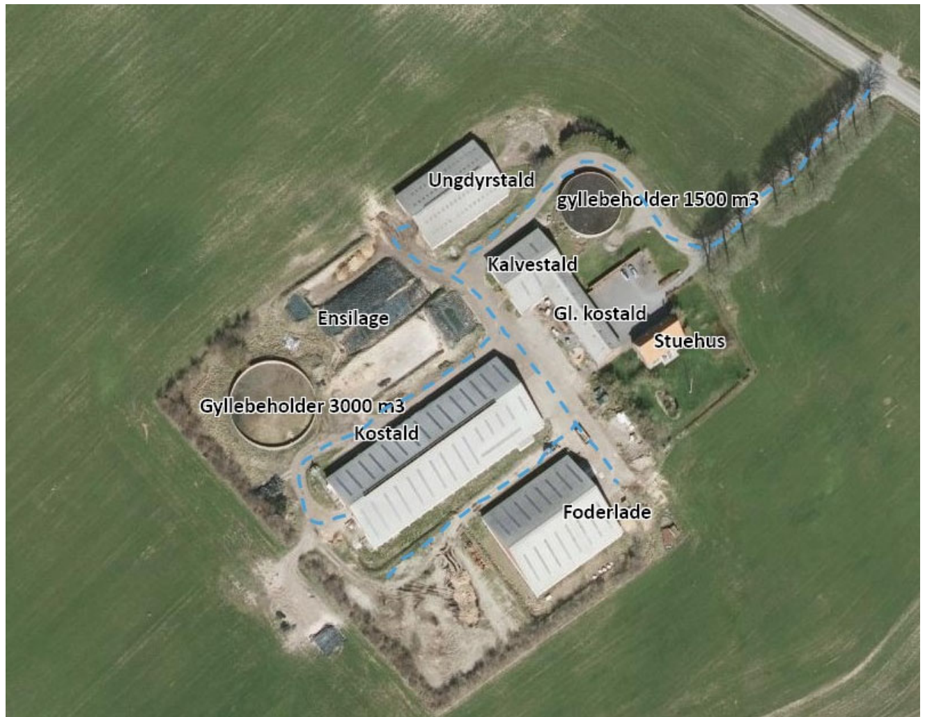
Figur 6 Anlægget på Trommeregård
