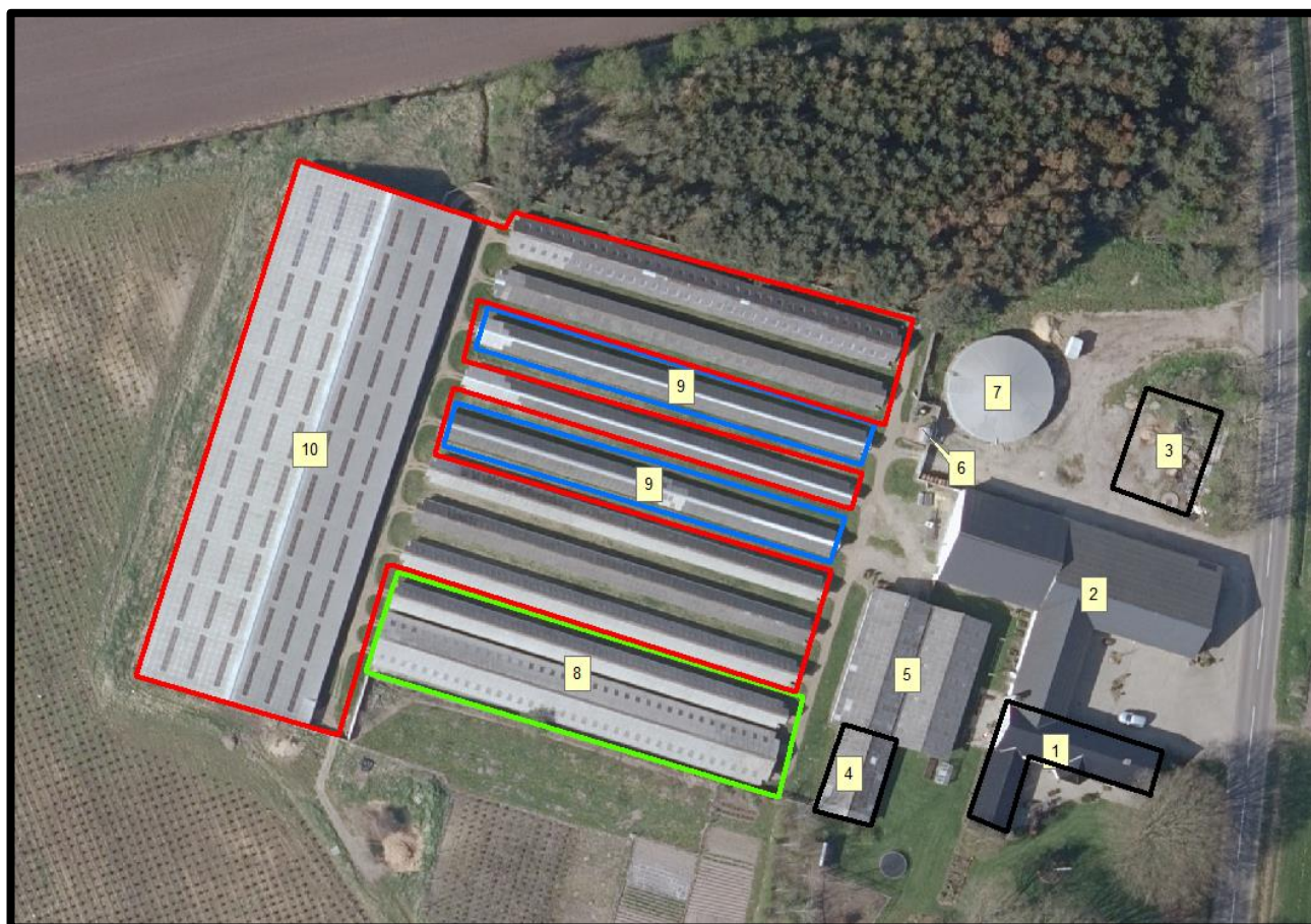
Figur 3. Oversigt over minkfarmens bygninger.
