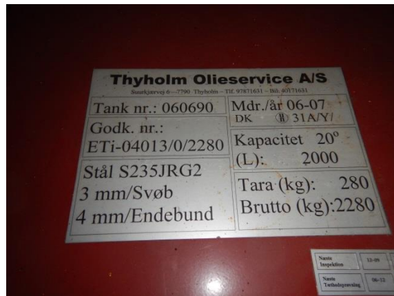
12. Mærkeplade på dieseltank.
