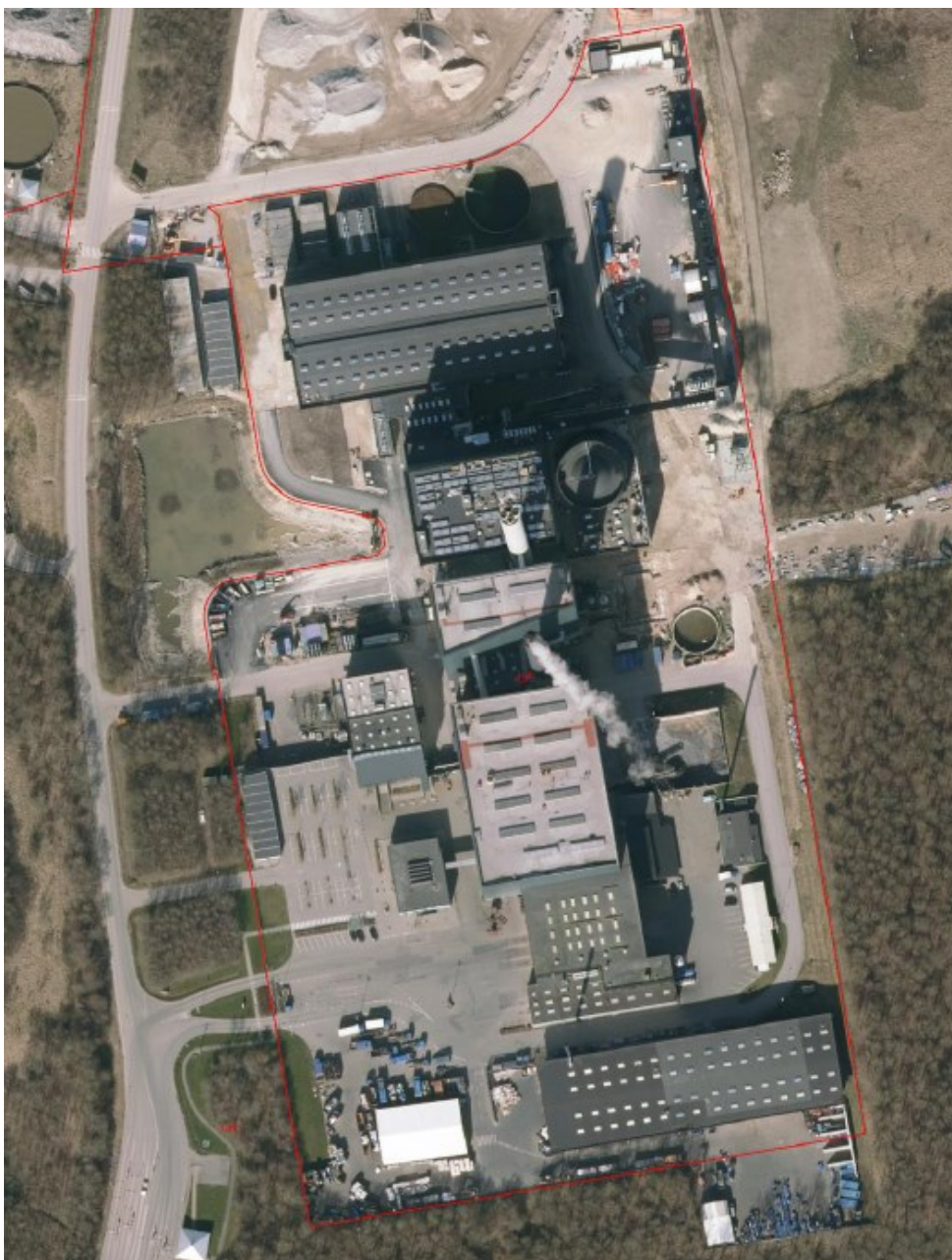
Luftfoto fra foråret 2017 af AffaldVarme Aarhus (AVA) AffaldsCenter, Forbrændingsanlægget og BKVV på den nordligste del af matriklen. Lager og containeroplæg på den sydligste del af matriklen er ikke en del af forbrændingsanlægget.
