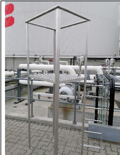
Der etableres platforme til at lette vedligeholdelsesarbejdet
