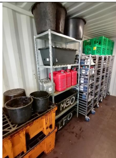
Opbevaring af farligt affald og produkter. Det aftales på tilsynet at større beholdere/dunke, der stadig står på reoler uden spildbakke placeres på spildbakker.
