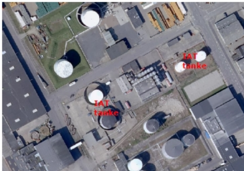
Figur 3 Overblik og placering af tanke i terminalen. Tankene er forbundet til en manifold med rørledninger, der er placeret over jorden.
