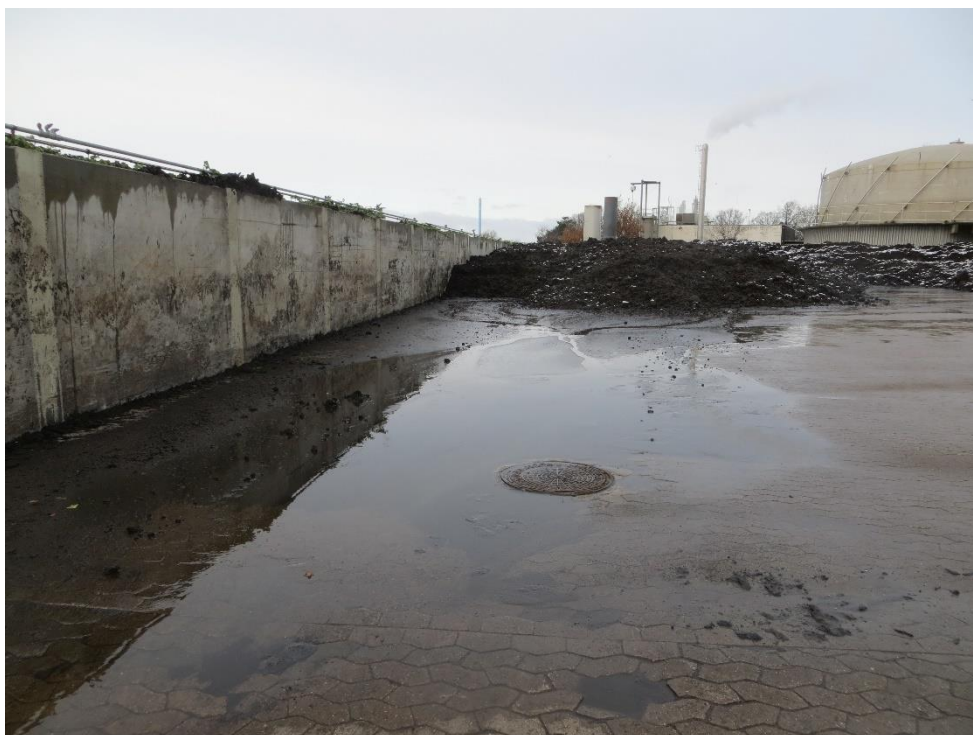
Slamlageret til stabiliseret slam med opsamlingsbrønde til overfladevand.
