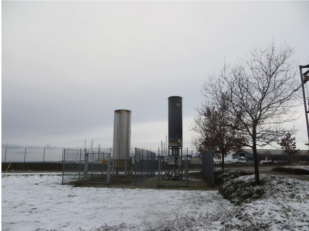
BIOFOS eget afkast til affakling er til højre. Nabovirksomhedens til venstre. BIOFOS skal forvente vilkår til begrænsning og registrering af gasudslip i revurderingen.
