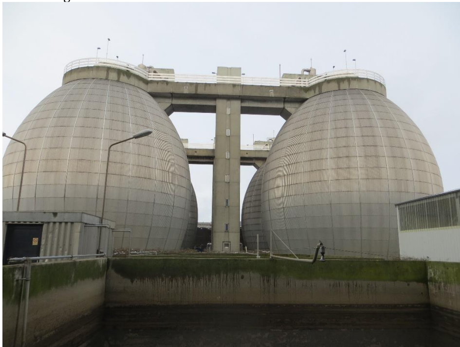
De 4 rådnetanke med metangasproduktion.
