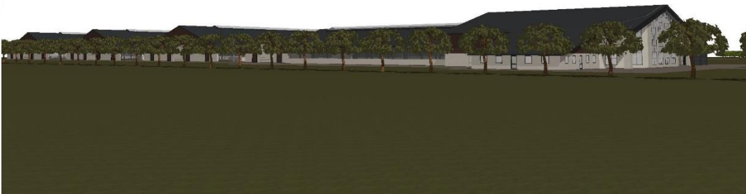
Anlægget set fra sydøst
