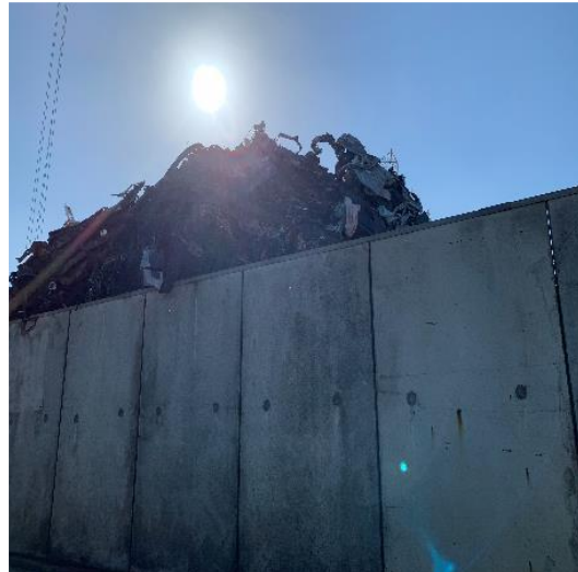
Nordlig mur, metalskrot op over muren og tæt på kanten
