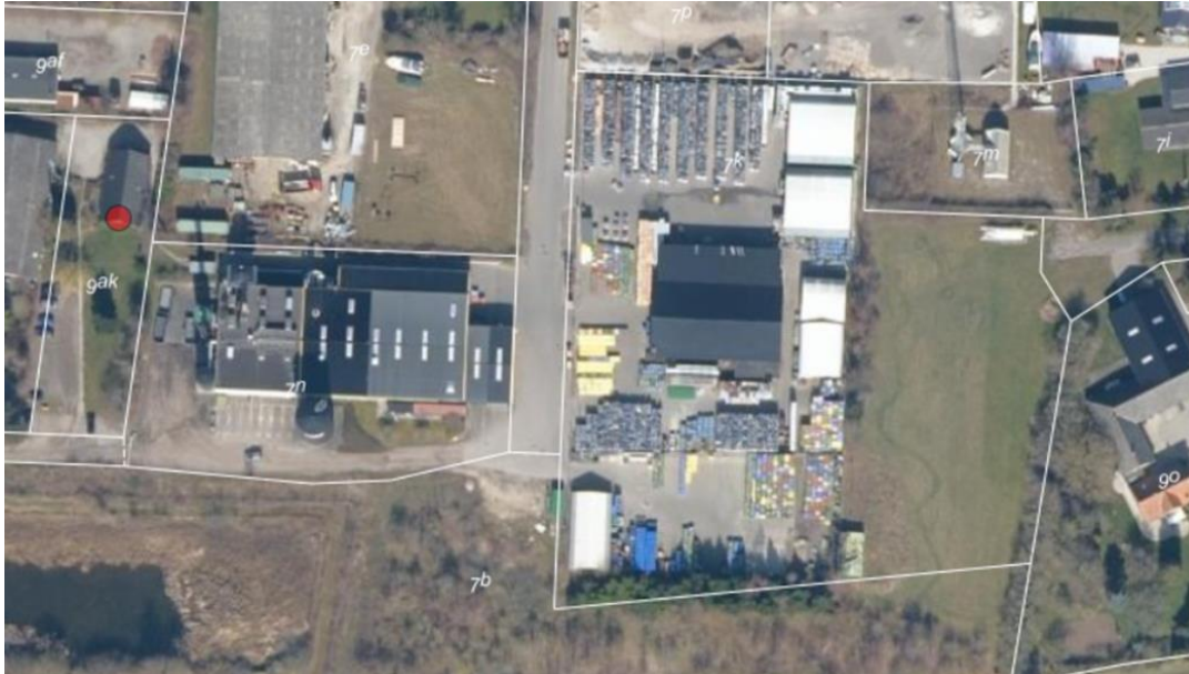
Ortofoto maj 2022. Oversigt over Special Waste Systems aktiviteter på Herthadalsvej 4a samt Peter Jensens Vej nr. 4b, nr. 8, nr. 10 og nr. 22, 4840 Nr. Alslev. Lagerplads 22 (højre del af 7k) er nu etableret med belægninger, hegn og port.
