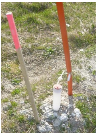
Foto 10: Boring på enhed 1C til beluftning af deponiet.
