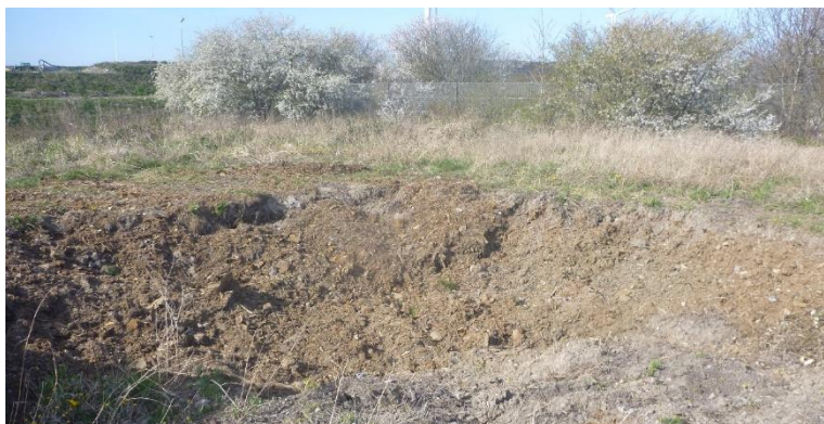
Foto 2: Udgravning af shredderaffald på enhed 2B. Den øverste meter er deponiets slutafdække, og derunder ses shredderaffald.
