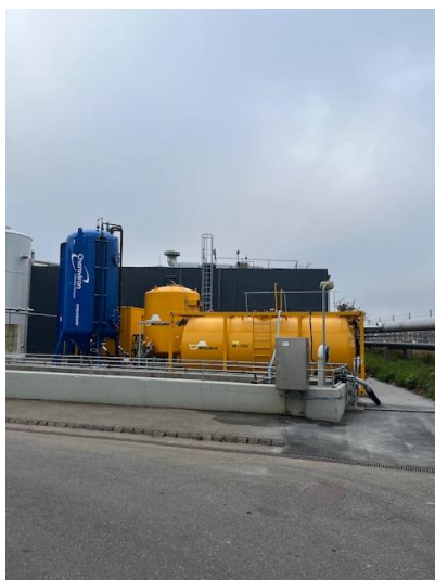
Nyt kulfilteranlæg
