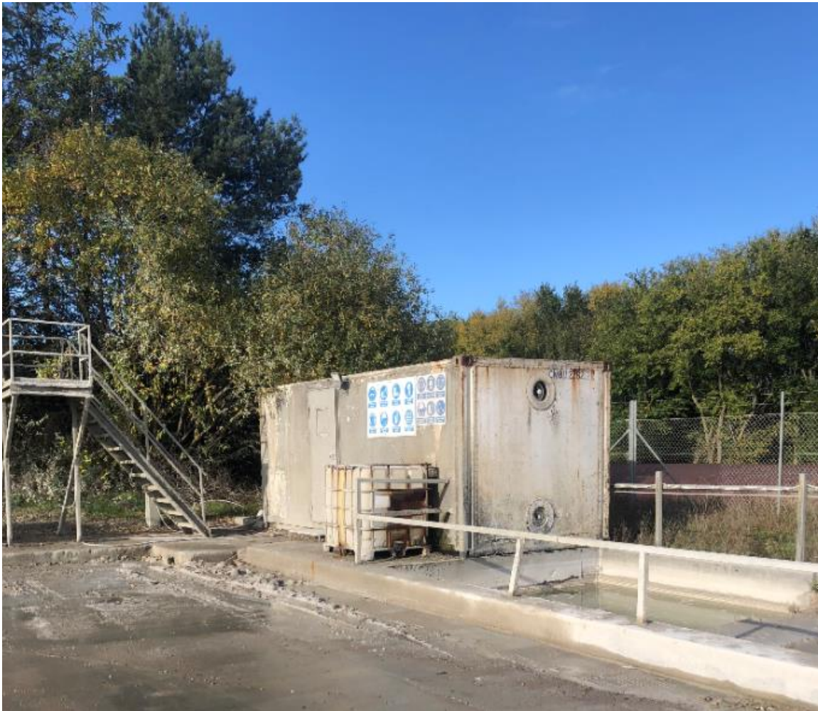
Billede 2. Palletank som er placeret udenfor i tilknytning til neutraliseringsanlægget (billede fra tilsyn i 2021)
