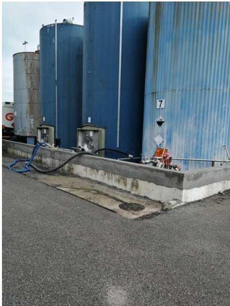
Billede 3. Tankgård med forhøjede vægge.
