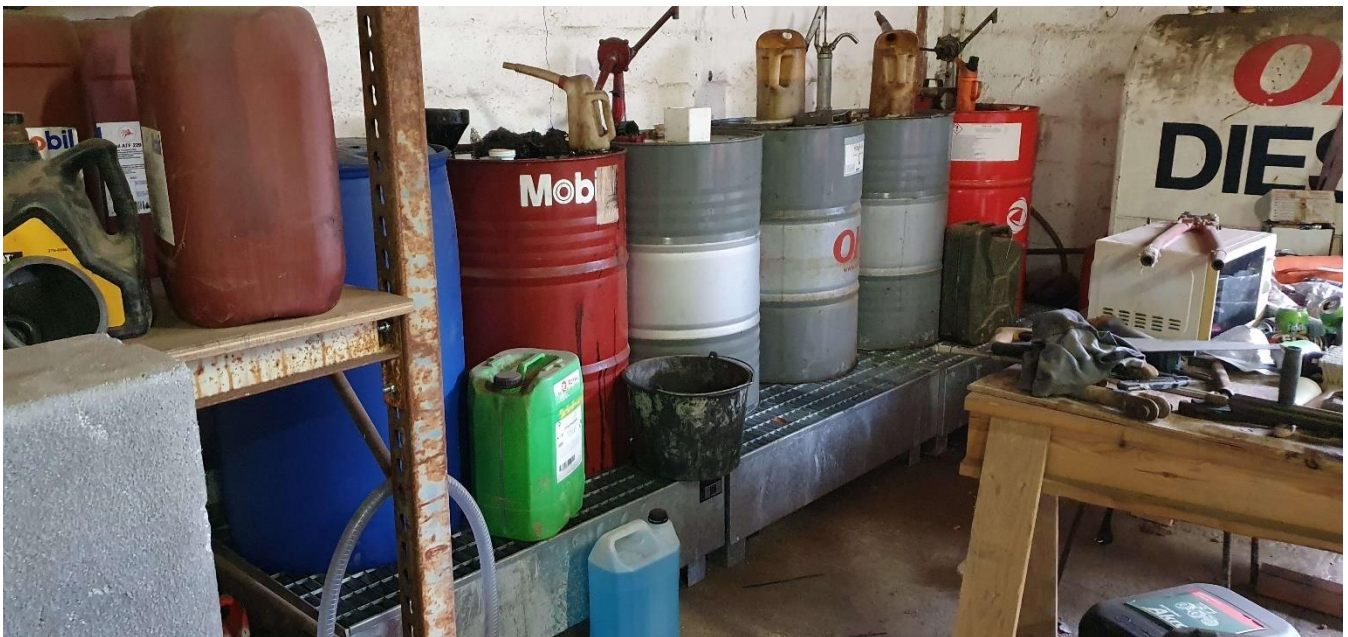
Olie m.m. opbevares på værkstedet med spildsikring.
